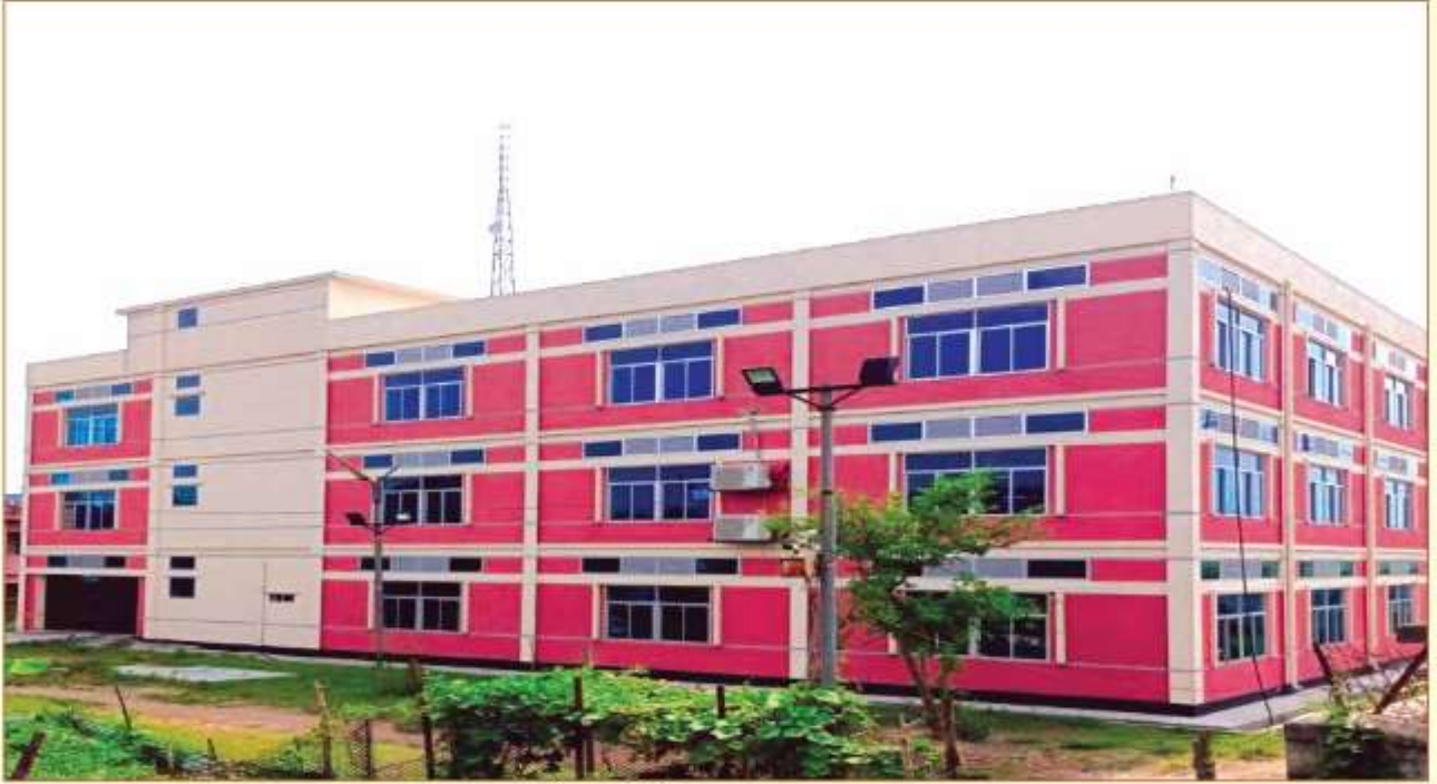
চিত্রঃ নবনির্মিত কোর স্যাম্পল ভবন
